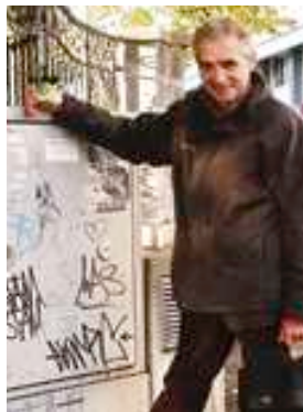
Les armoires électriques taguées passeront aux oubliettes. mfe
